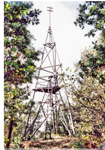
Nieistniejąca już wieża triangulacyjna na jednym z wierzchołków Raduni (źródło – dolny-slask.org.pl )
